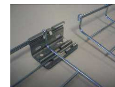
5) Installer une éclisse sur la 1ère longueur
