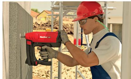
Le nez d'éjection spécial E-Fix permet de fixer les matériaux d'isolation.
