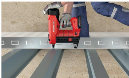
Pour la fixation temporaire de planchers métalliques sur des poutres en acier.
