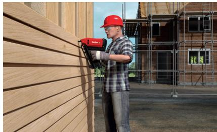
Un capuchon pour protéger la surface du bois dans les zones visibles, par exemple pour le bardage extérieur
