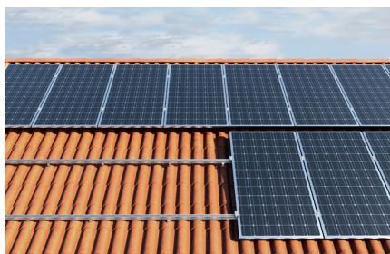
Toiture inclinée avec couverture en tuile canal
